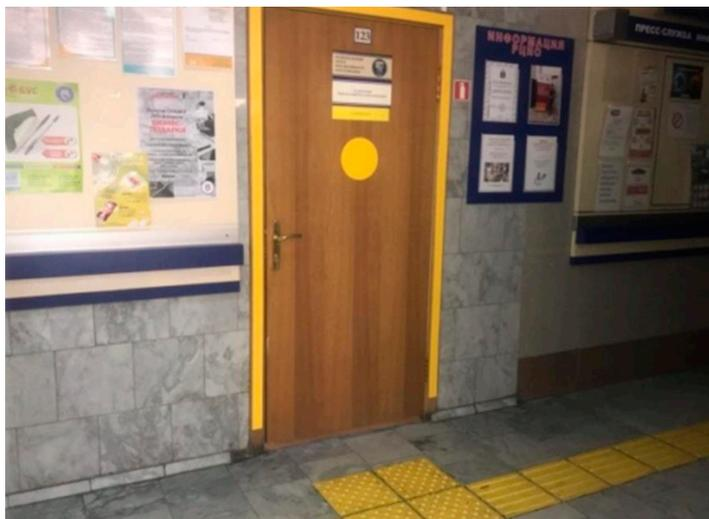
*Рис. 54.* Дверь с индикатором безопасности
